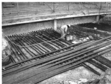
图 2 室外水平埋管施工现场
