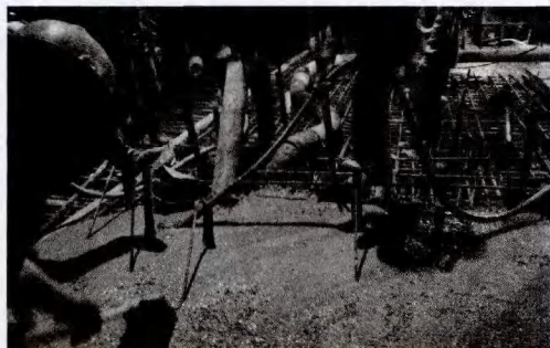
图9 保果金沙江特大桥主桥连续刚构节段浇筑振捣
